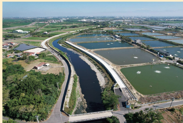
岸內排水治理工程一、二期完工，有效提升鹽水地區防洪效能
