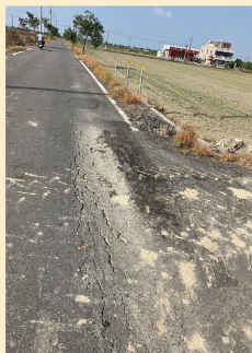
114年度鹽水農地重劃區(北路4-6)農路改善工程改善前
