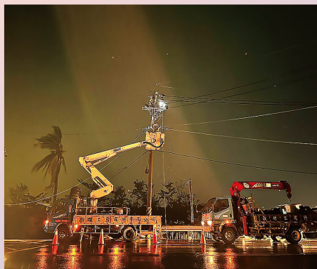
台電連夜冒雨搶修
