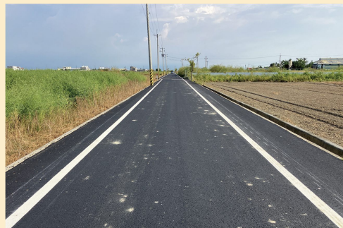
114年度鹽水農地重劃區(北路4-6)農路改善工程改善後
