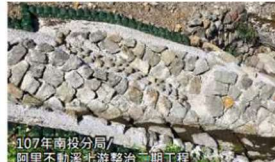
護岸設置粗糙斜坡式動物通道
