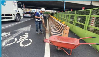
工區周邊環境整理
