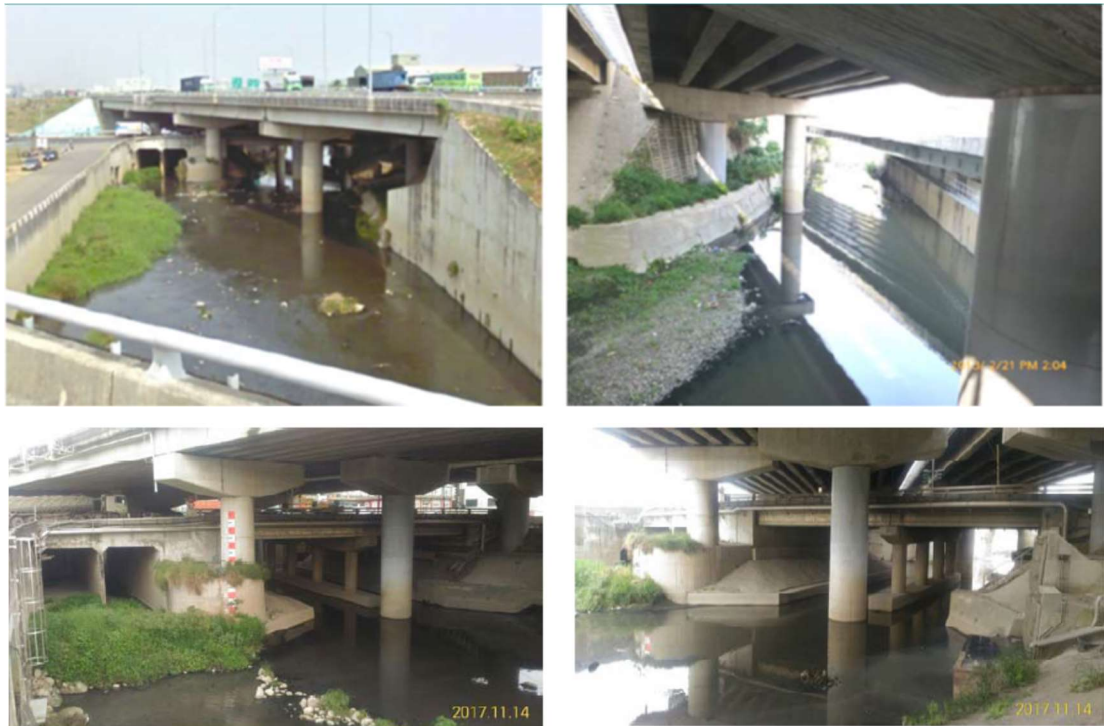
圖 2、高速公路及萬代橋橋端影響水流断面
