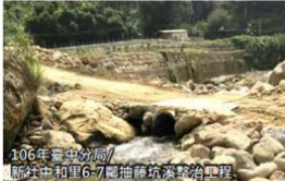
機具過溪床處鋪設過管
