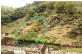
治理前-坡面治理時保留部分樹木殘根，提供良好種原
