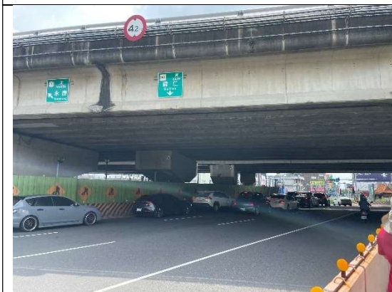
說明：便橋通行現況 拍攝日期：113年7月21日
