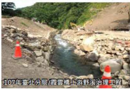
半半施工、維持常流水
