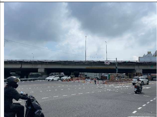
說明：便橋通行現況 拍攝日期：113年7月21日
