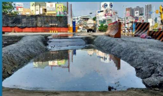
簡易洗車池設置
