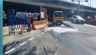
施工中道路清潔維護
