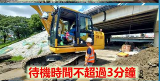
基礎施工打樁取代明挖
