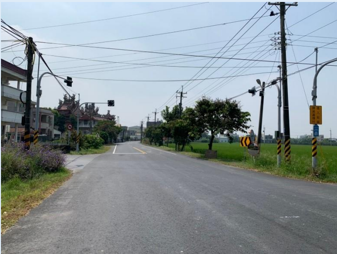
照片 1、南 63 線完工
