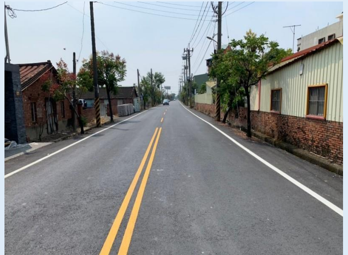
照片 2、南 68 線完工
