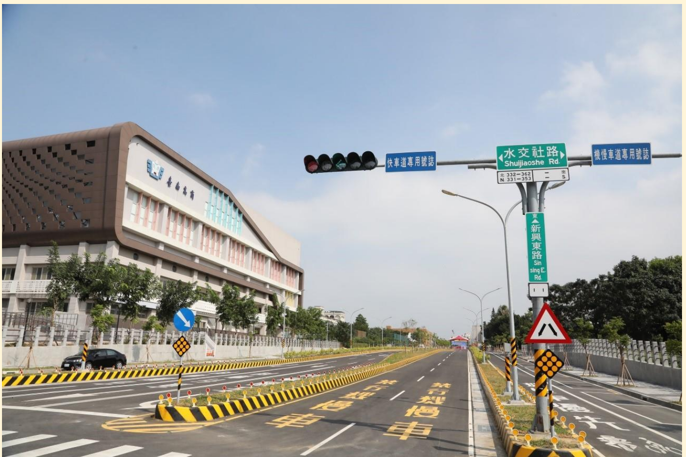
照片 2、完工照片
