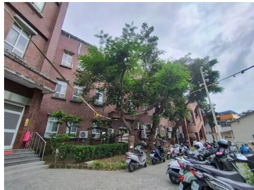
西側機車停車場完工(113.10.4)
