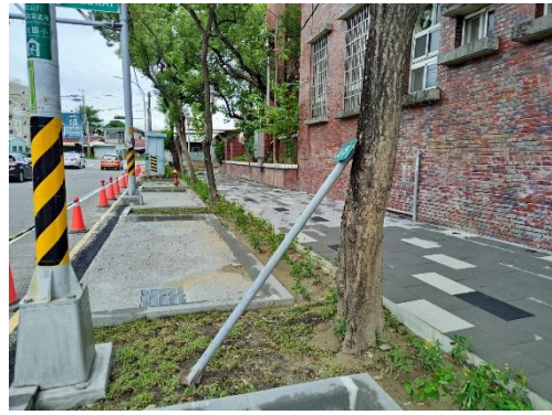
人行道排水溝完工(113.10.4)
