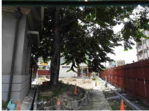
區公所西南側沿路現況(113.8.30)
