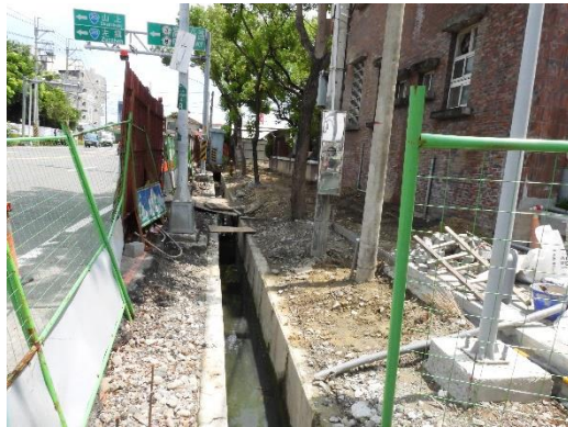
人行道排水溝施作現況(113.8.30)
