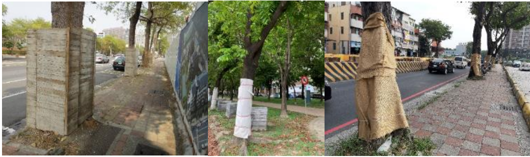
圖7.3 高雄市施工中樹木保護案例
