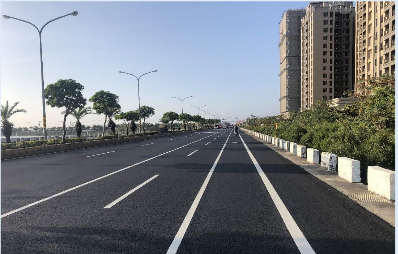
照片 1、安明路竣工照片
