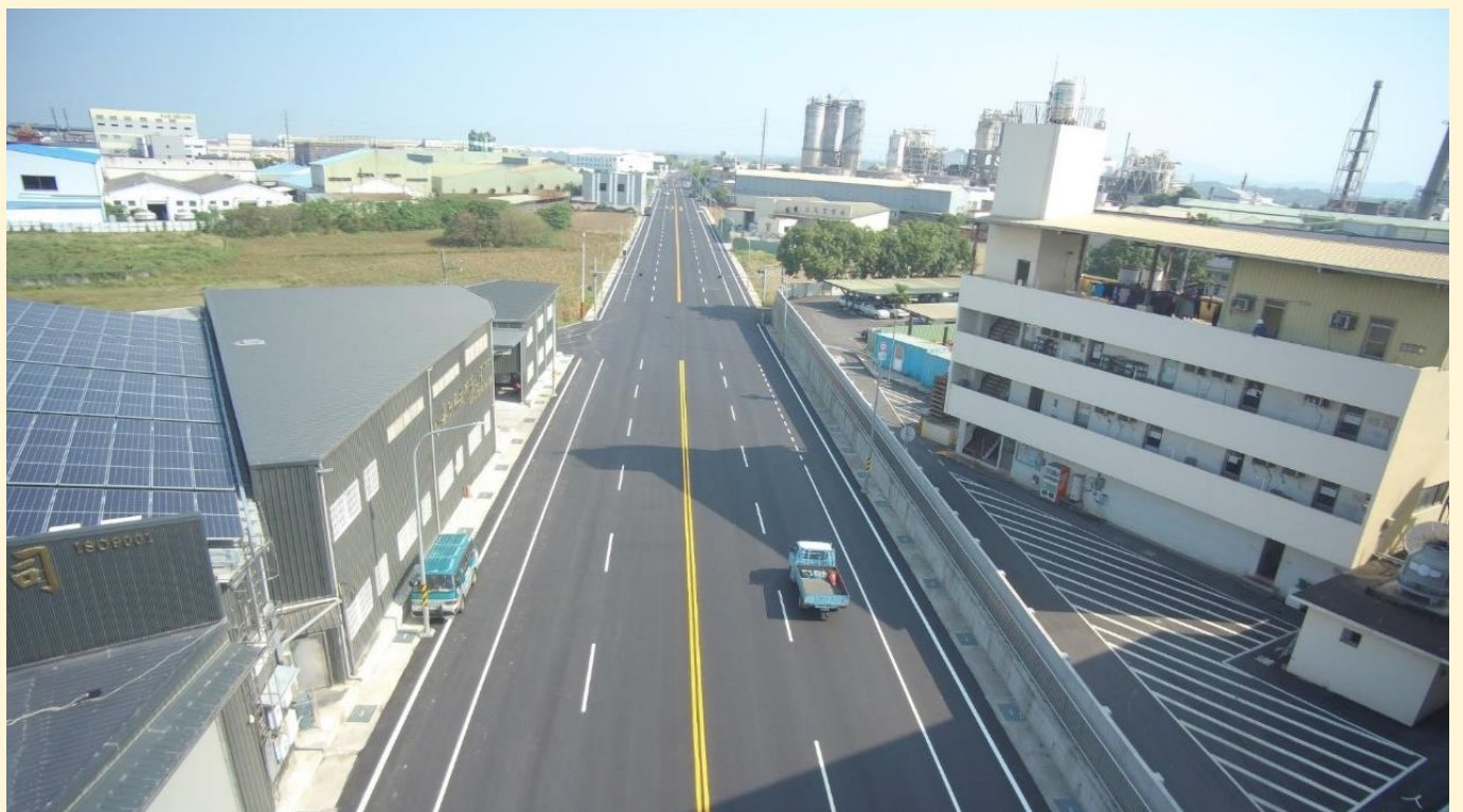
照片 3、完工照片
