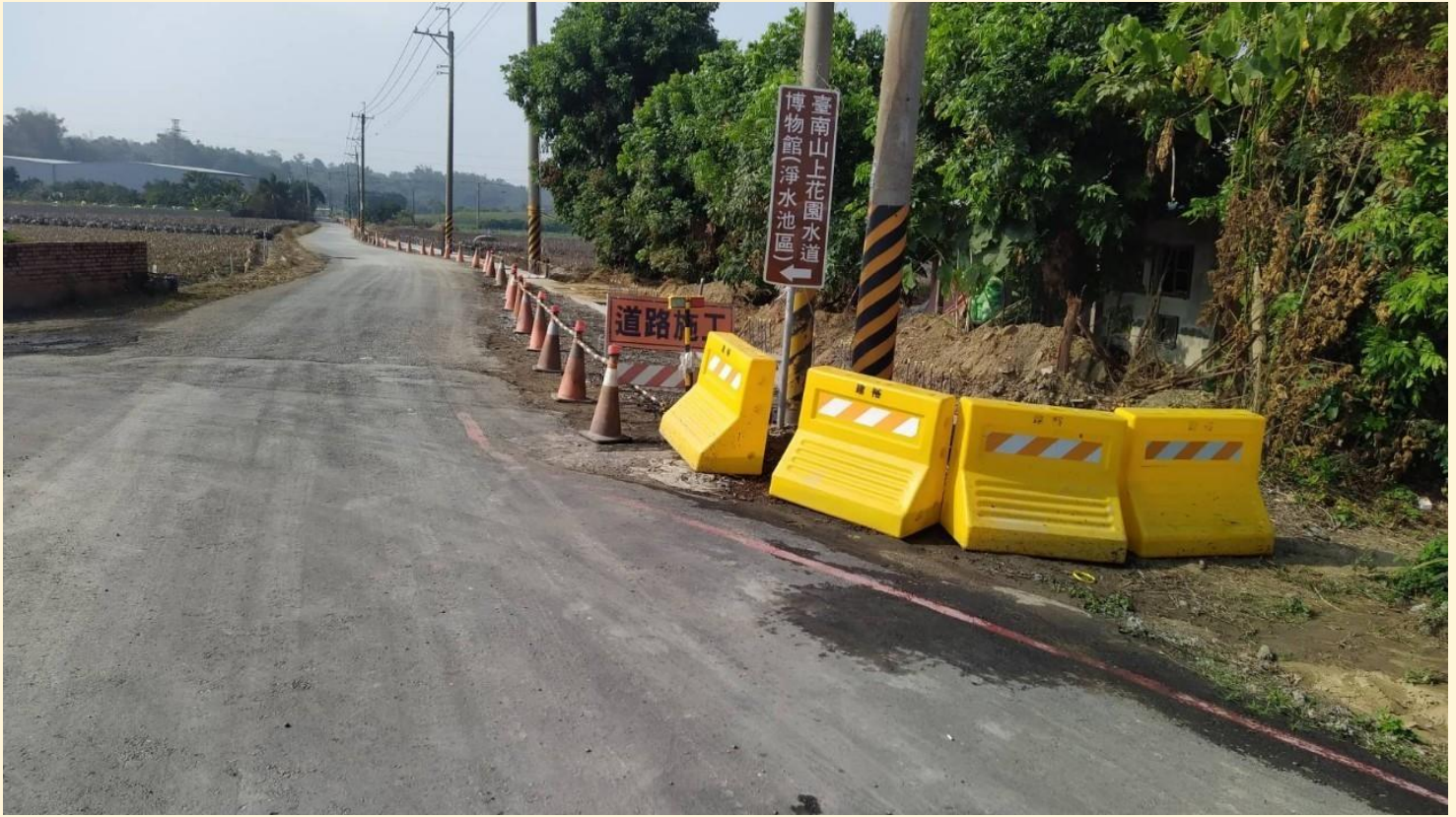
照片 2、施工中照片(春節前預備)
