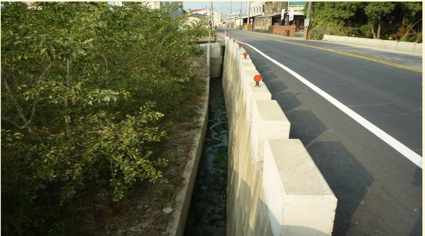
照片 3、橋梁北邊路段西側新建擋土牆及側溝
