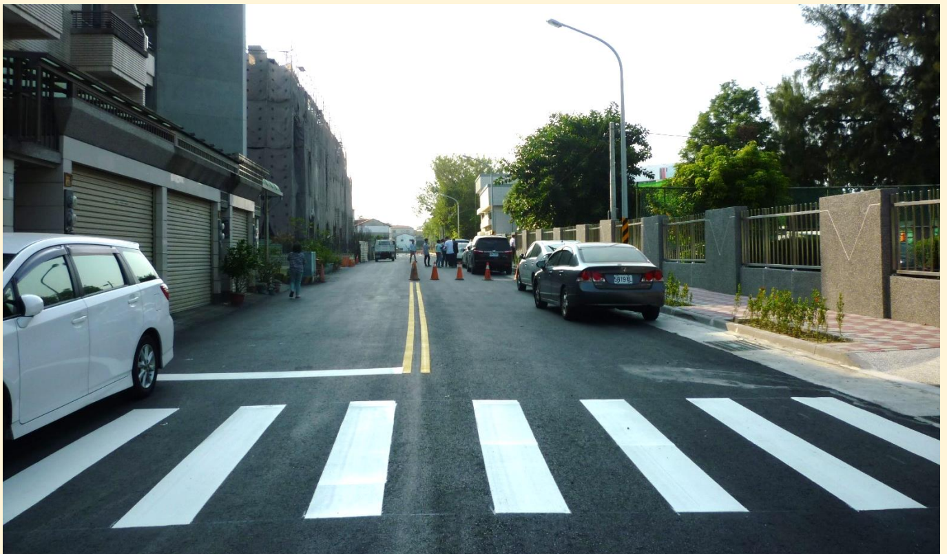
照片 3、學校圍牆退縮讓人行道變寬(施工後)
