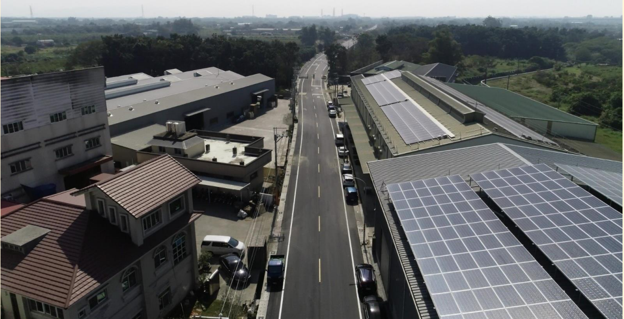
照片 2、沙崙站銜接南 154
