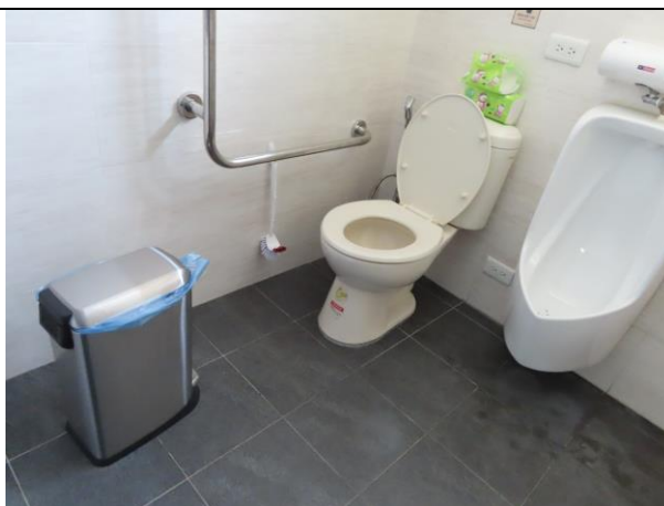
名稱：白河區清潔隊2F性別友善廁 地址：臺南市白河區河東里糞箕湖3號
