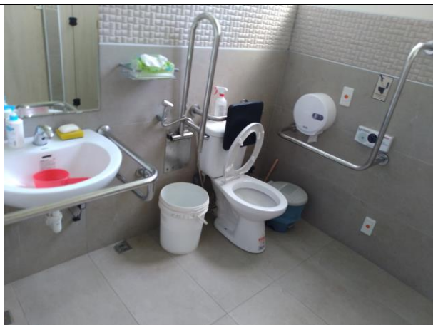
名稱：左鎮區衛生所性別友善廁 地址：臺南市左鎮區中正里中正172號之15
