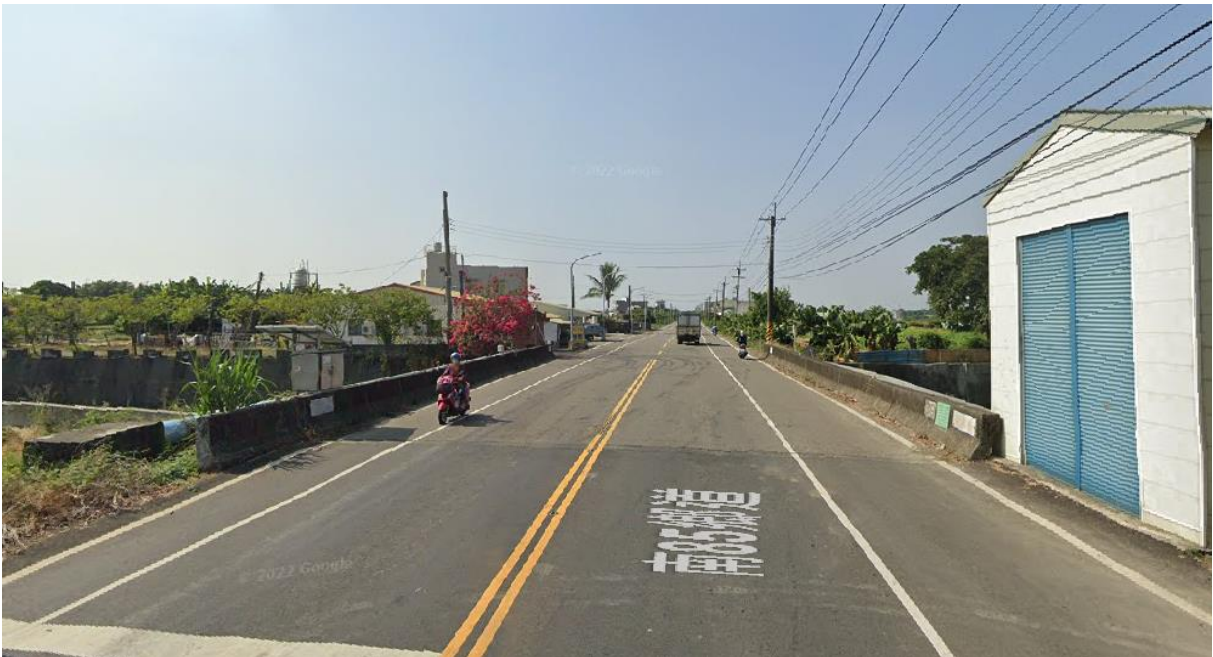
圖 24 南 85 軸線現況照片
