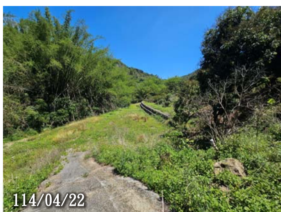
下邊坡石籠擋土牆現況照片
