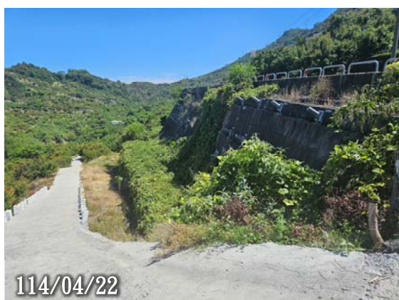
下邊坡地錨擋土牆現況照片
