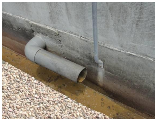
定期清洗排水管與排水溝
