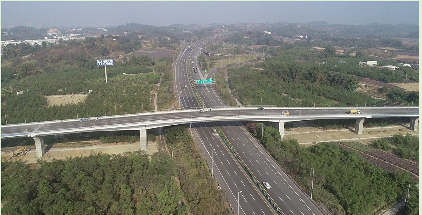
照片 2、20M 聯外道路(跨越國 3 高速公路)
