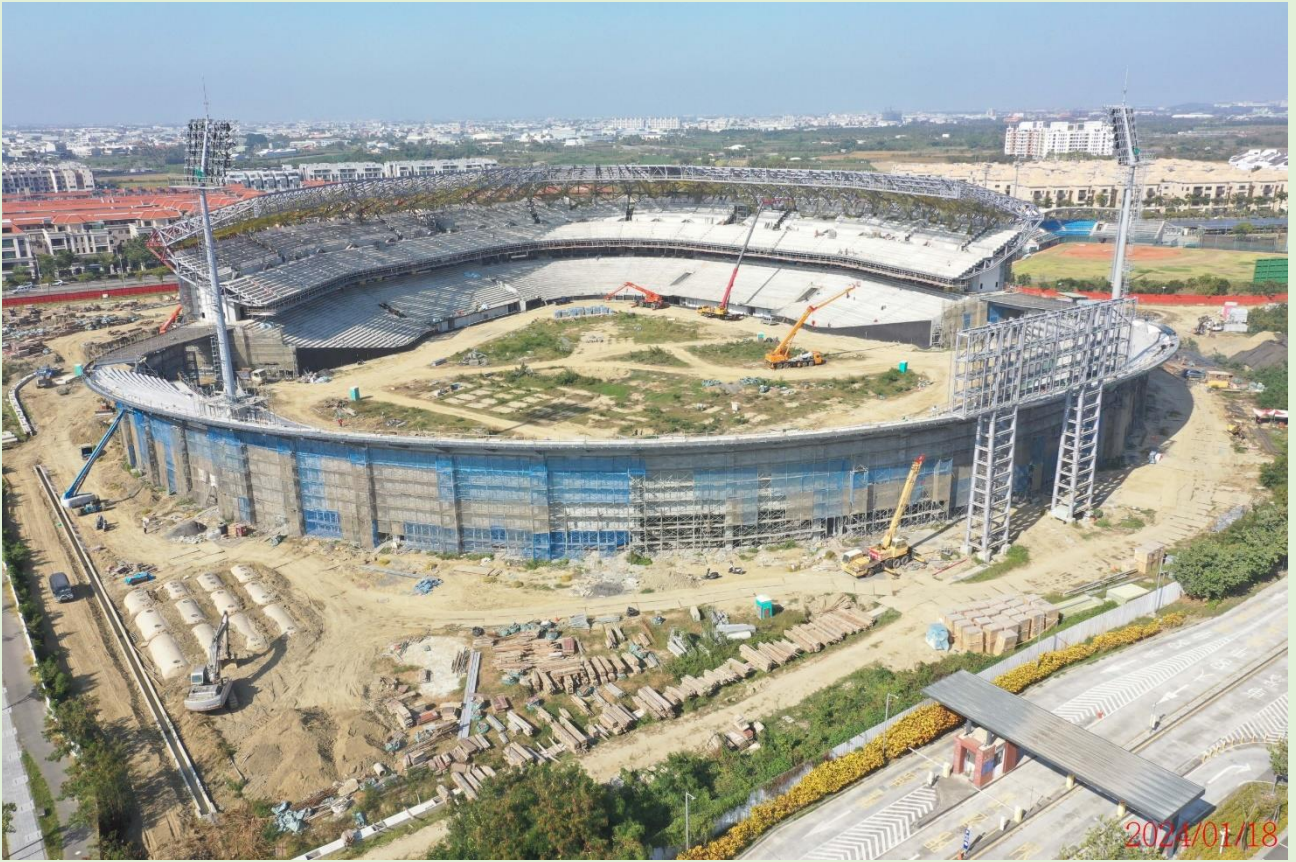
照片 3、成棒主球場施工外觀
