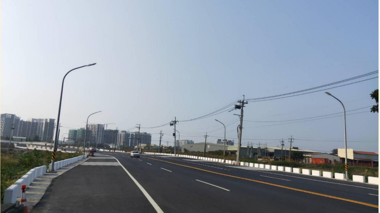
照片 2、永寧橋完工路面現況平整
