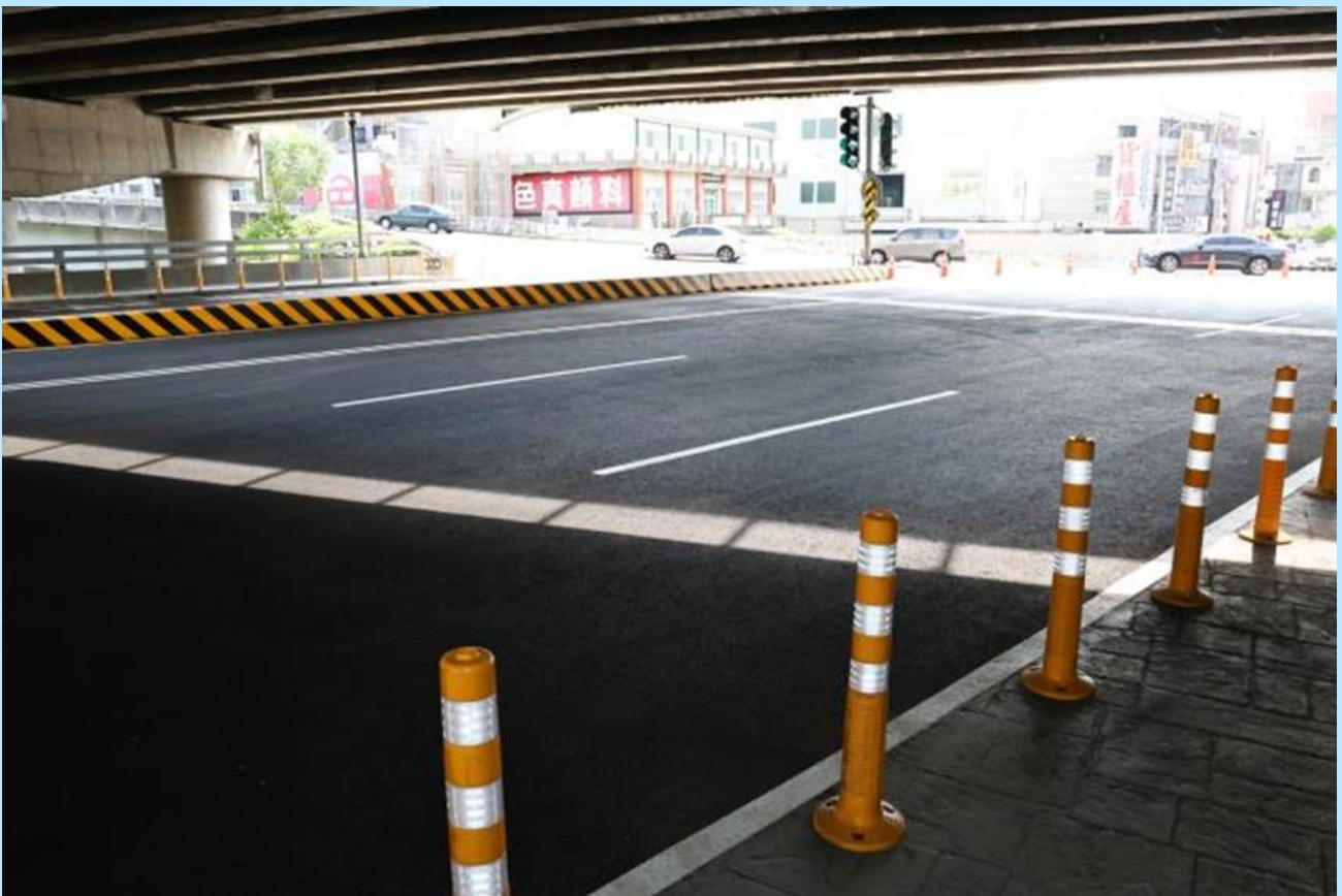
照片 2、萬代橋橋樑主體工程
