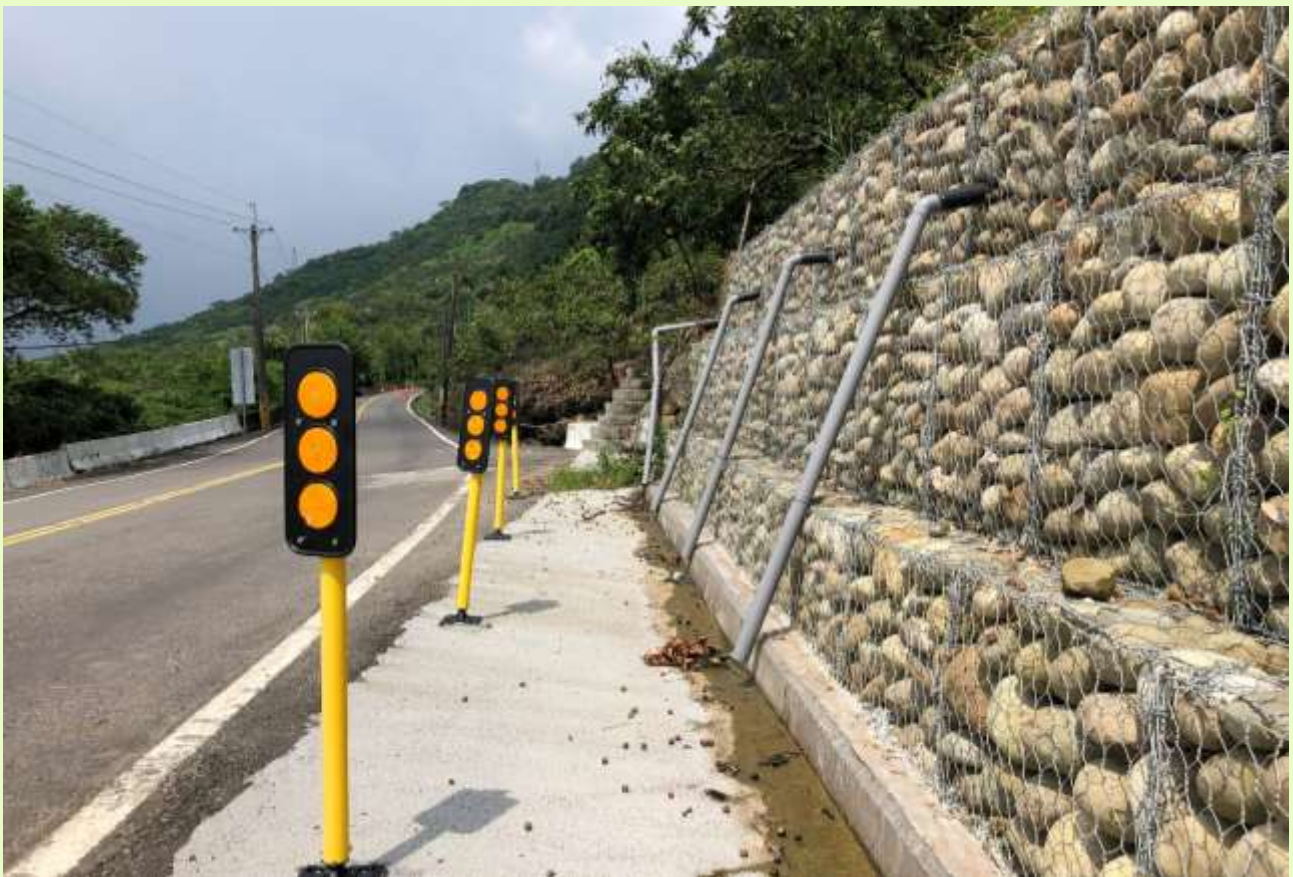
照片 2、「市道 175 線 25.4K 地滑區」採創新三層次治理邊坡降水治理策略
