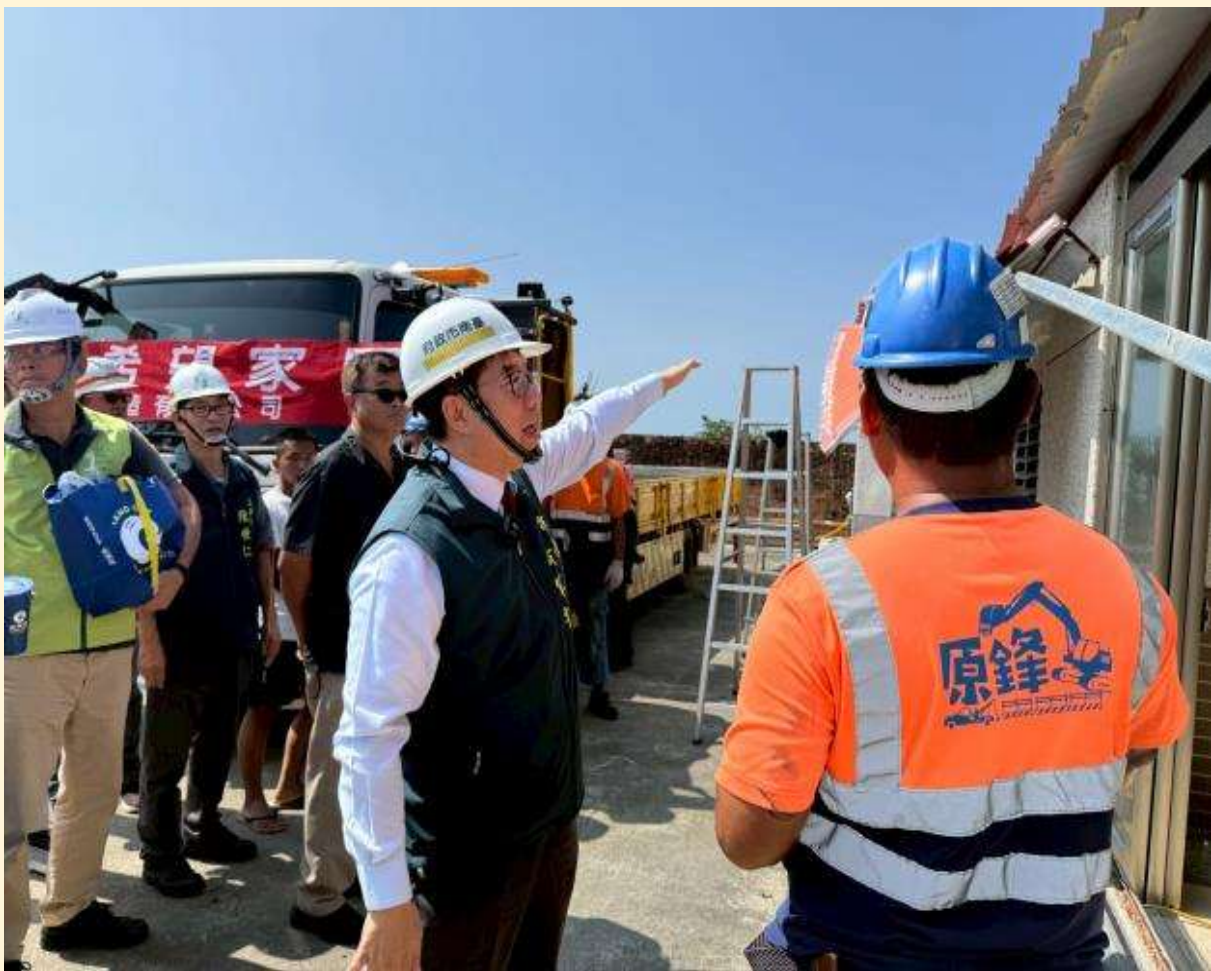
照片 1、市長視導修繕情形
