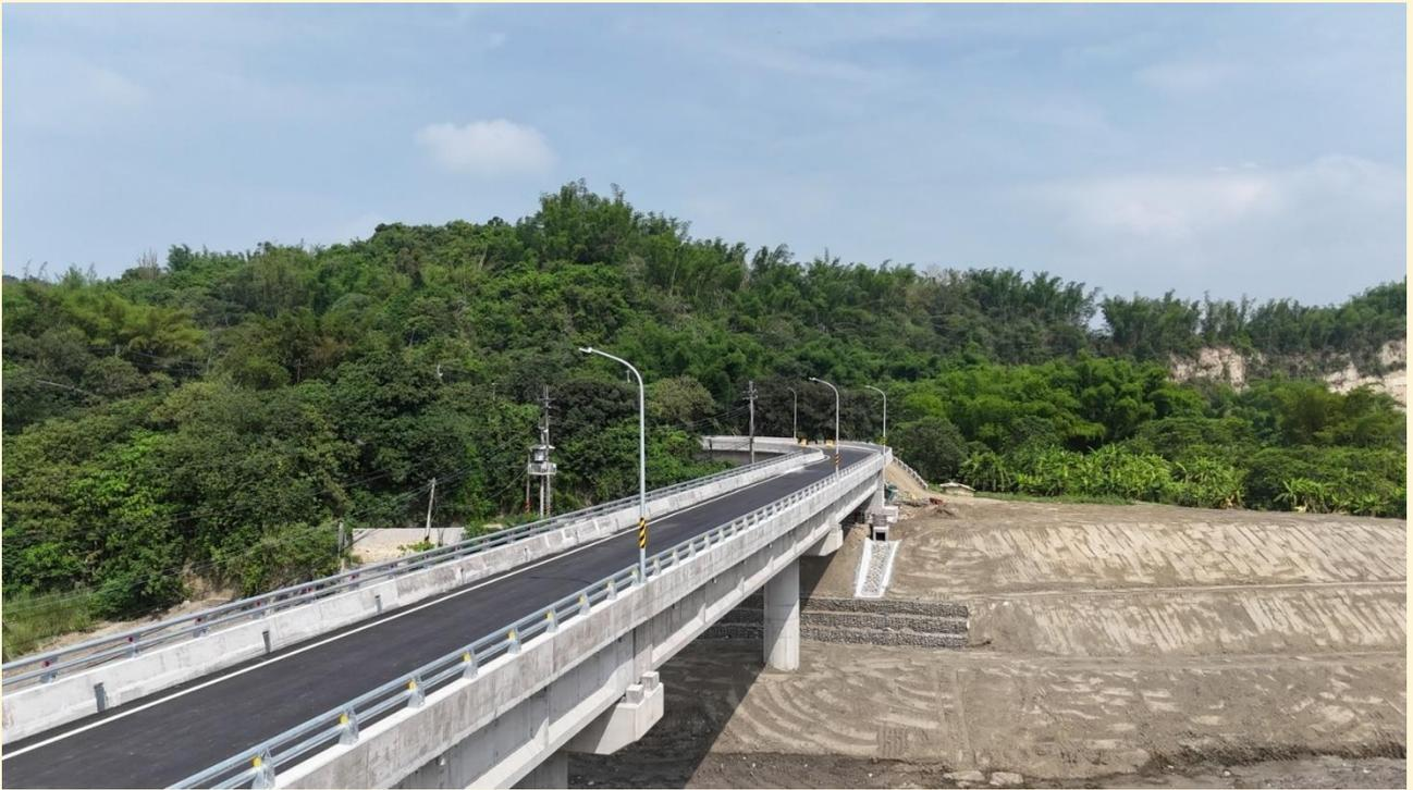
照片 2、橋樑型式採雙跨預力混凝土 I 型樑橋
