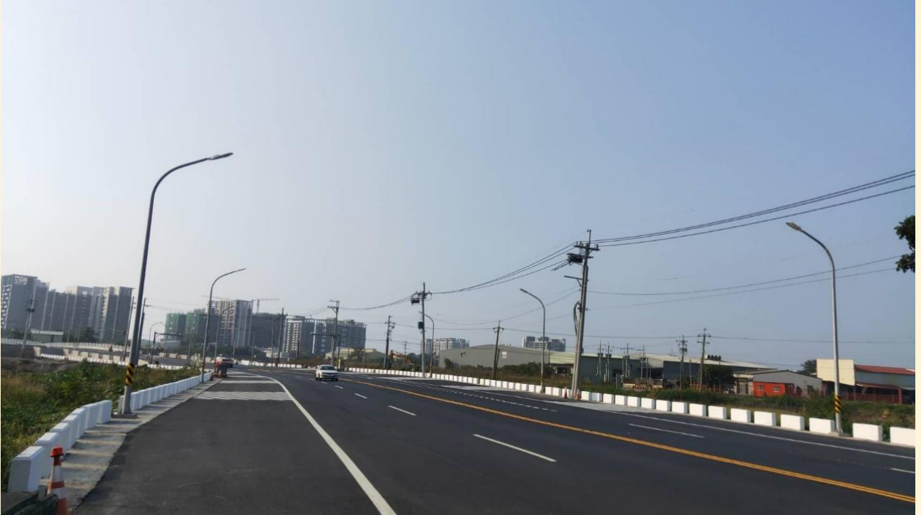
照片 2、永寧橋完工前路面現況平整
