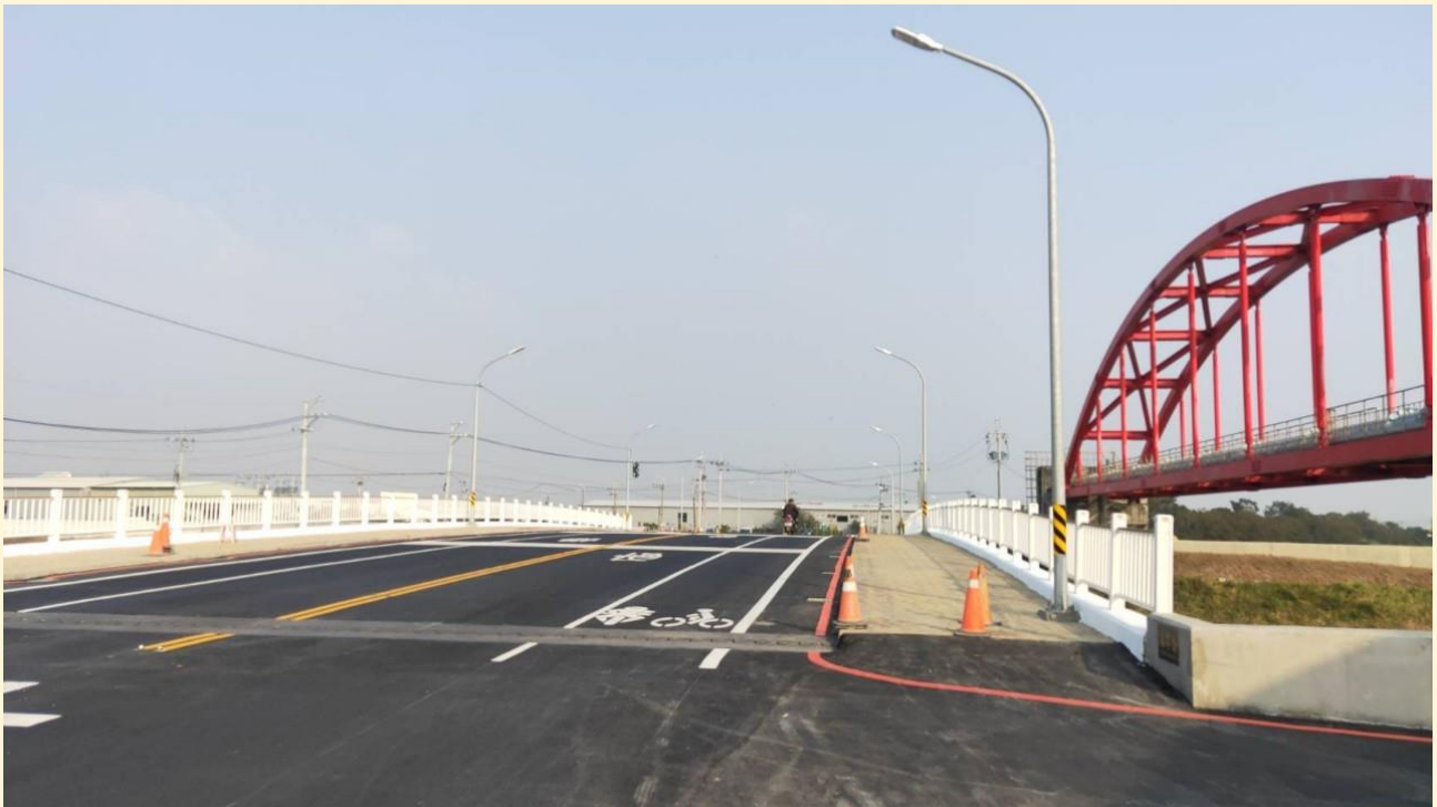
照片 1、永寧橋完工現況
