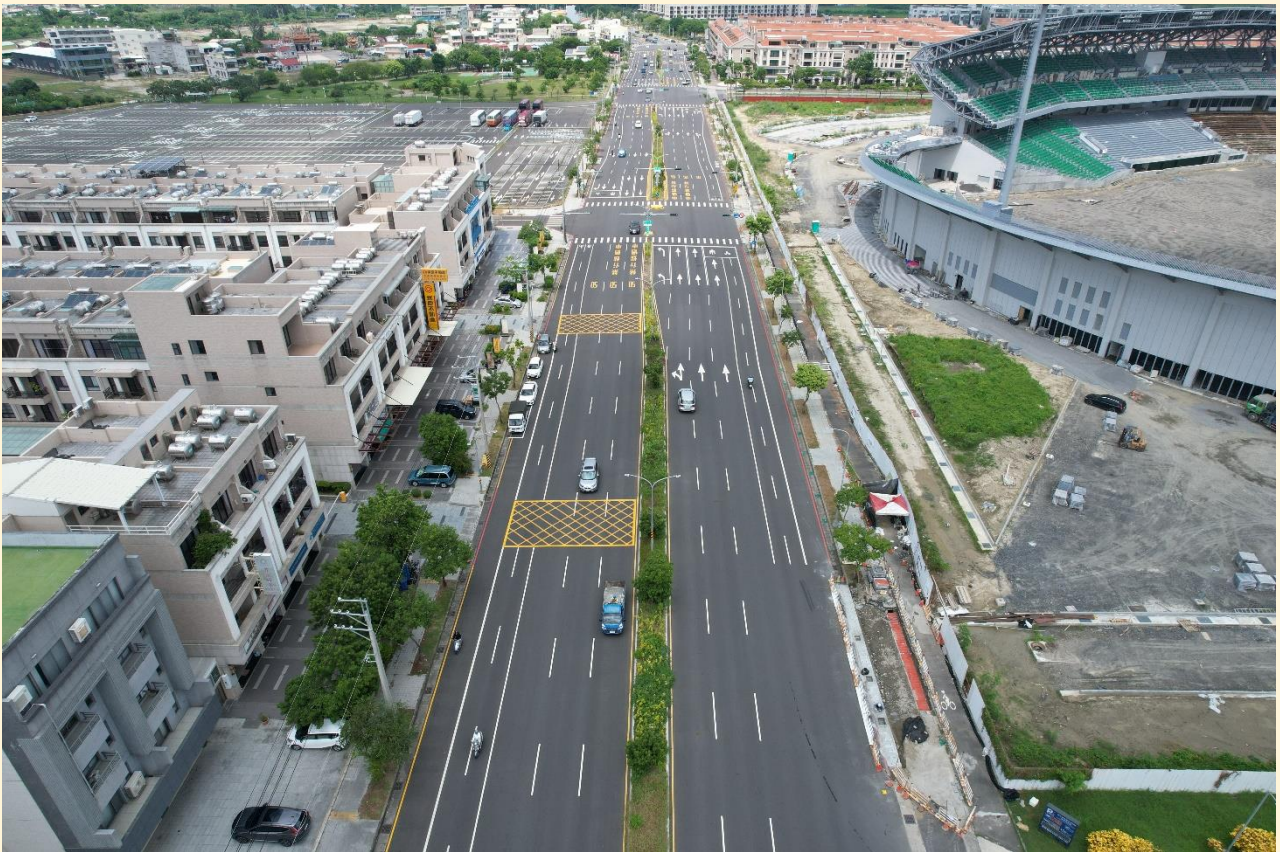
照片 1、完工照片
