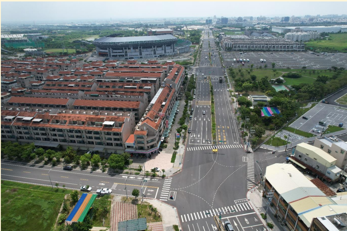
照片 2、完工照片
