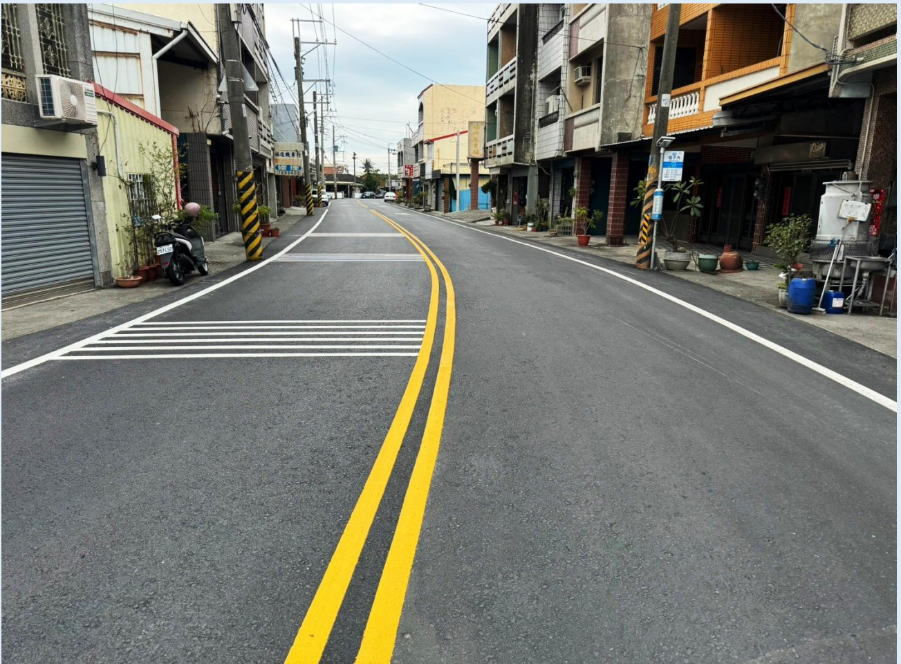
照片 1、南 37 線完工後照片
