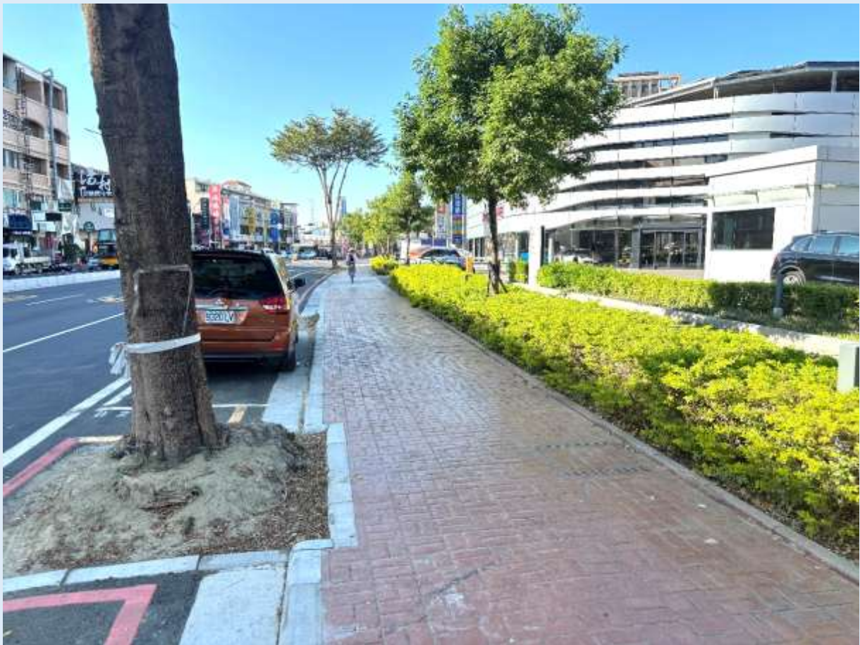
照片 1、完工後寬敞平整行人通行空間
