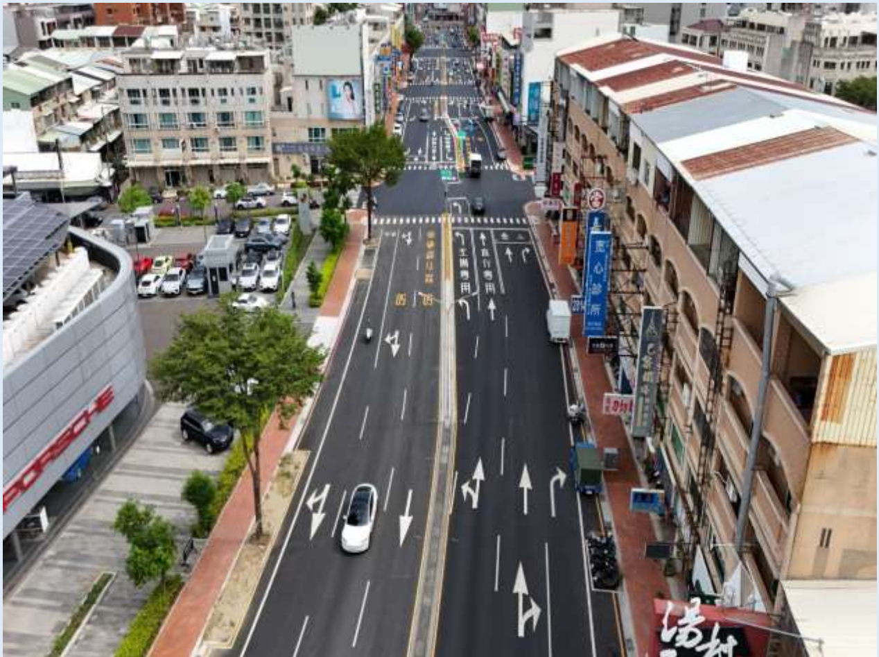
照片 2、高規格道路創鋪並增設左轉彎專用車道
