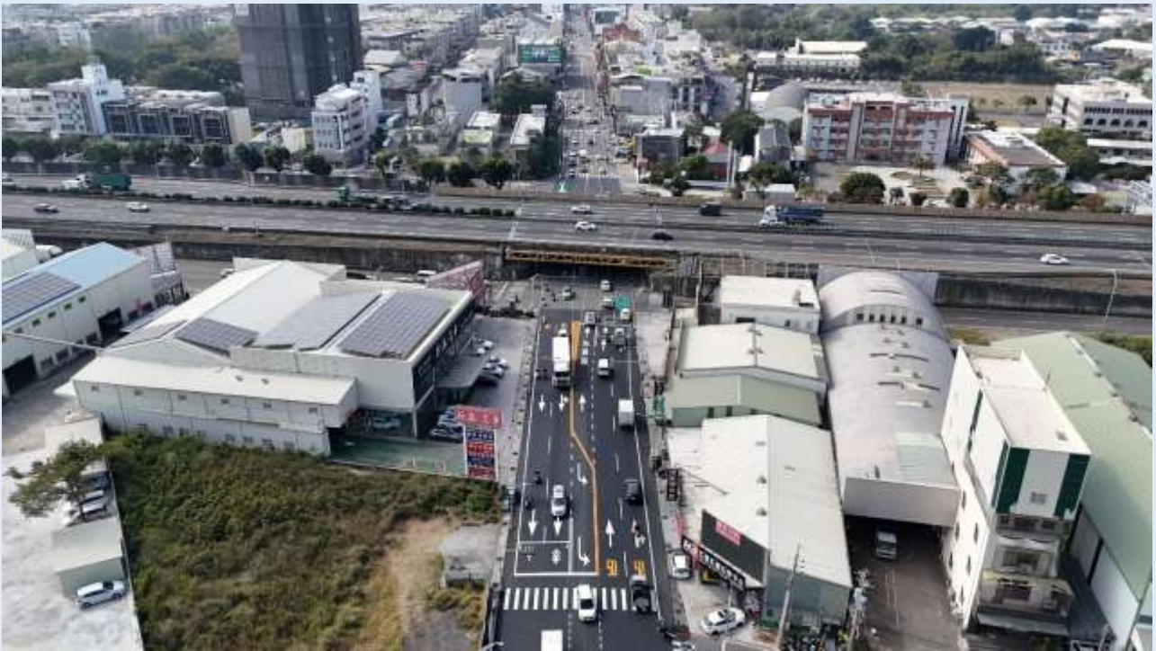
照片 2、往裕義路增設左轉附加車道完工空拍
