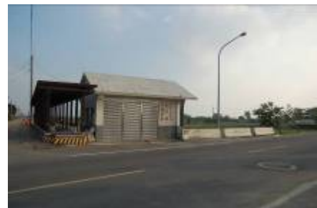
位於聚落南側南 85 線的抽水站
