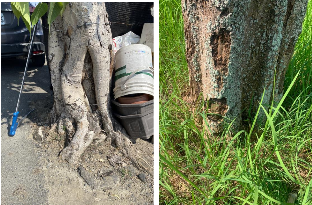
圖 33 根部機械性損傷
