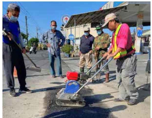
陳村長與路平志工修補路面坑洞
