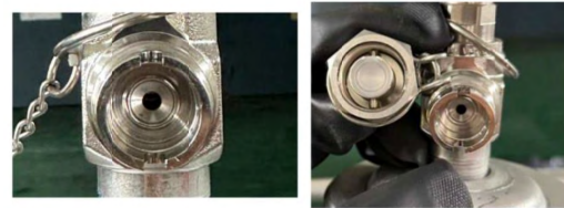
20230816 16:37 F2 閥凸緣與墊片外觀再檢查 無殘留氣體與腐蝕跡象
