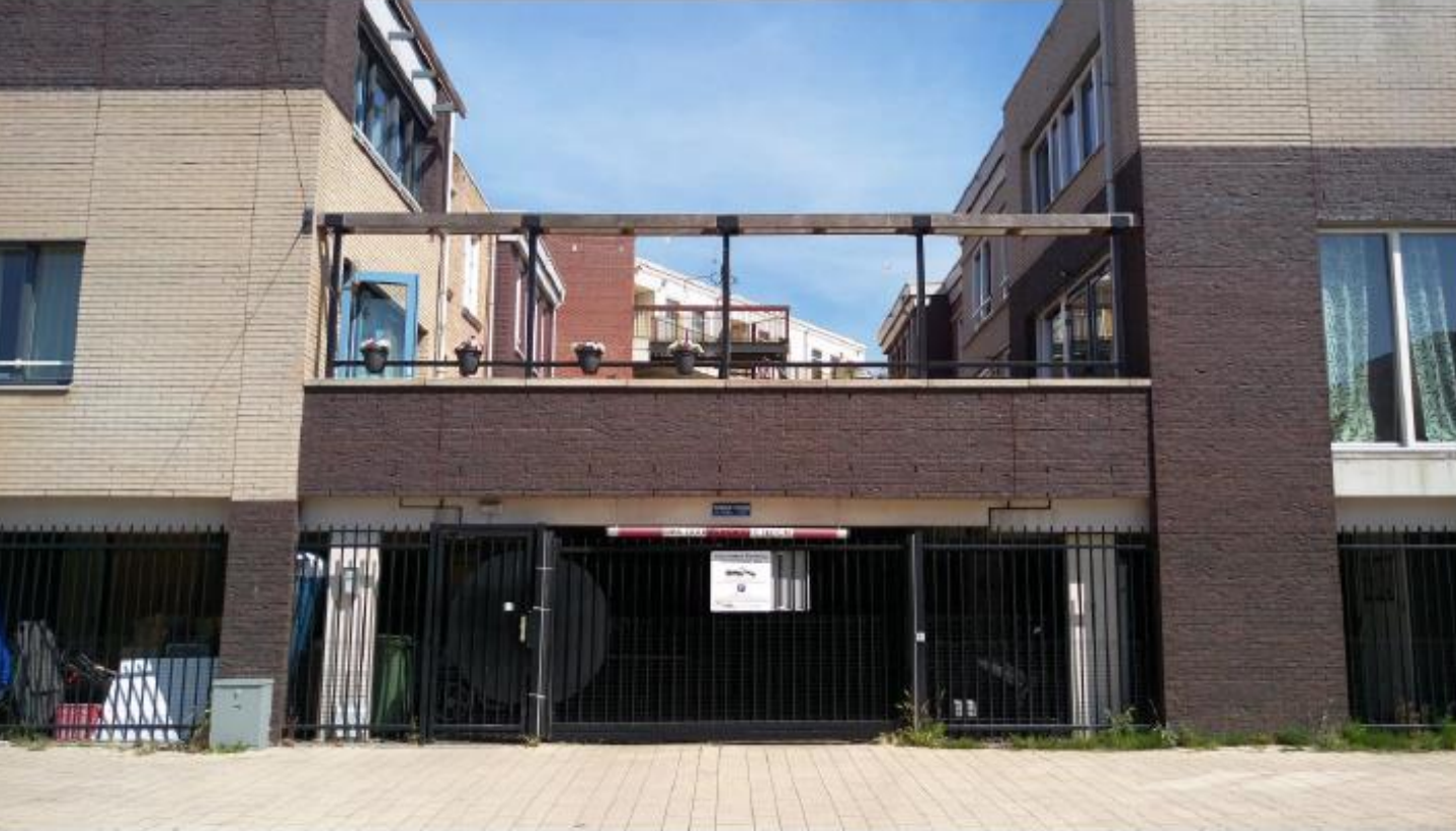
街廓建築住戶一樓的自用服務車道入口 車道口設置自動鐵門格柵 每住戶單元配置兩車位
