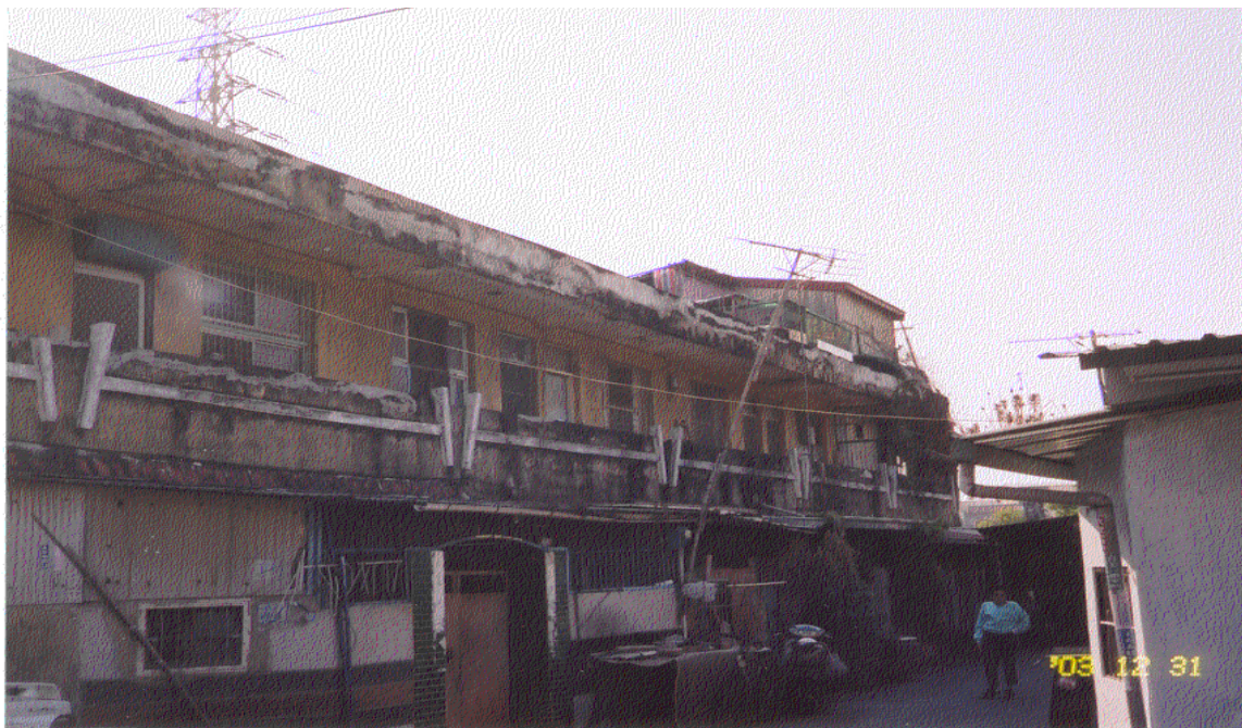
照片 4-7 大同平價住宅社區西側內部巷道環境現況圖
