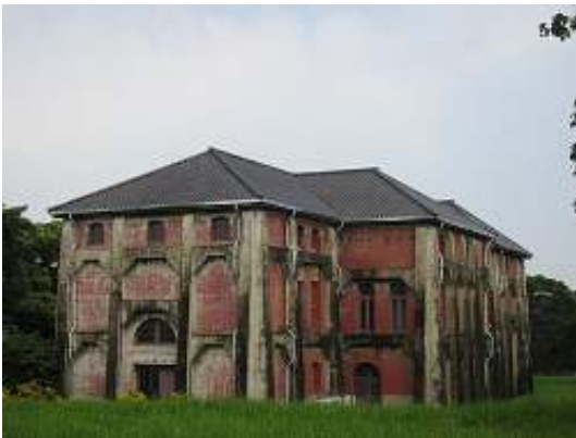
照片 2-2-6 臺南水道建築
