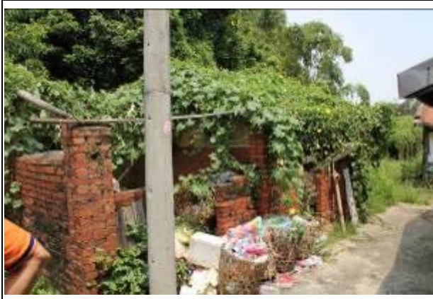
內角 84 號附近老舊房舍成為垃圾堆放區，有礙環境衛生。
