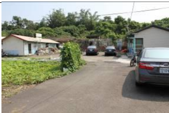
8 鄰 101 號女媧宮旁民宅因年久失修腐鏽破舊，有牆傾屋瓦掉落之危險。
