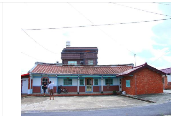
長短樹 32-1 號，殷金重古厝，具傳統建築風貌
