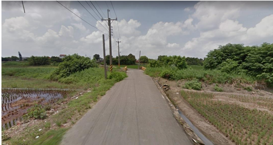
圖 46 崩埤大排沿線現況照片
