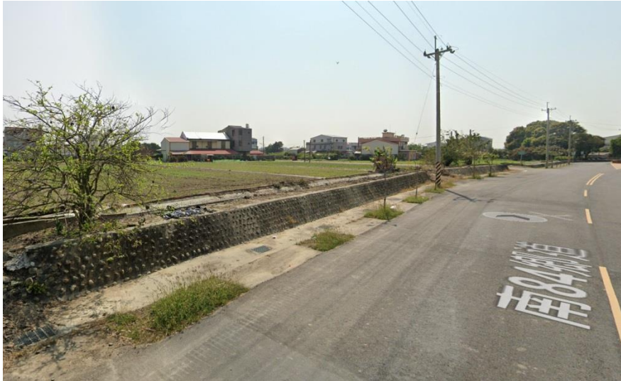
圖 45 南 84 軸線現況照片
