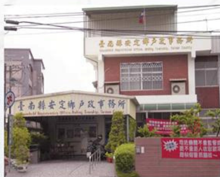
圖8-3-14 安定鄉戶政事務所
