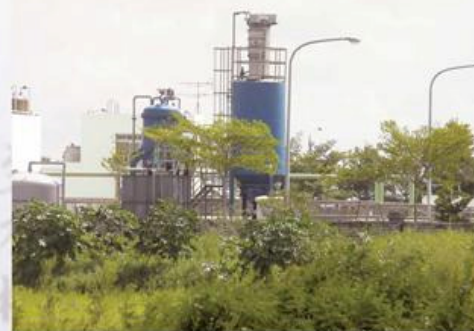
圖8-3-9 灰渣掩埋場及污水處理廠
