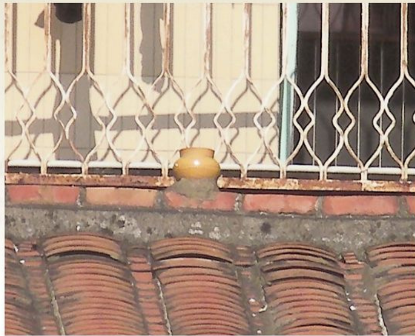
圖1-4-5 港口村有在屋頂放瓦甕的特殊習俗
