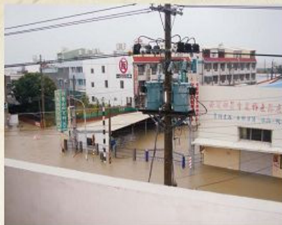
圖1-4-2 八八水災本鄉的水患災情 資料來源：安定鄉公所提供，2009.08.08
