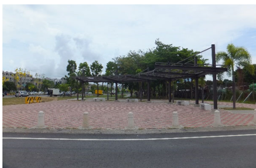
A. 基地南側灣裡街公園現況
