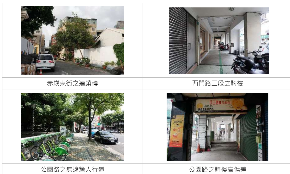
圖197. 赤嵌樓、祀典武廟及大天后宮周邊人行空間現況照片
