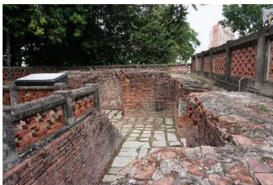
圖50. 東北角稜堡遺跡與東面臺基
