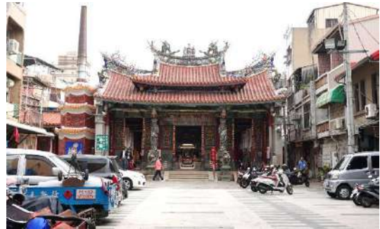
圖54. 現況三川殿歇山重簷的樣貌
