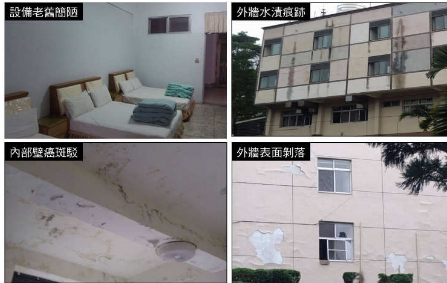
圖 2-2-2 建物設施現況照片
