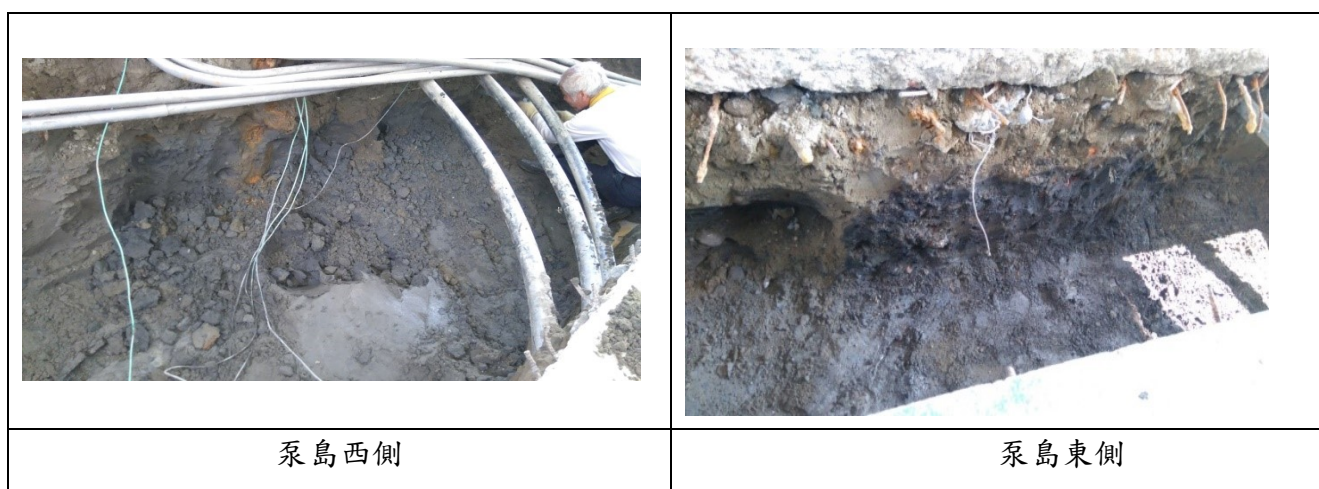
圖 4.3-30 機車泵島下方未飽和層土壤側向剖面之油品污染分布情形
