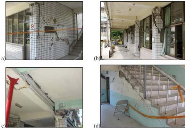
圖 2-3 玉井國中校舍損毀狀況 (a)忠孝樓牆面損毀 (b)仁愛樓樑柱與牆面破壞 (c)文化樓樓版破壞 (d)信義樓樓梯破壞狀況 (國家地震工程研究中心)
