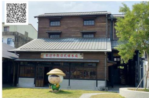
東山區農會日式碾米廠 ★文化部文化資產-歷史建築/產業設施
