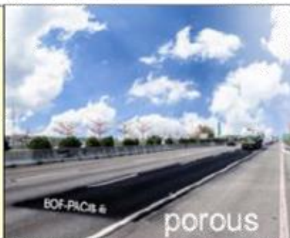
高速公路透水性瀝青 (Porous asphalt concrete free way)
