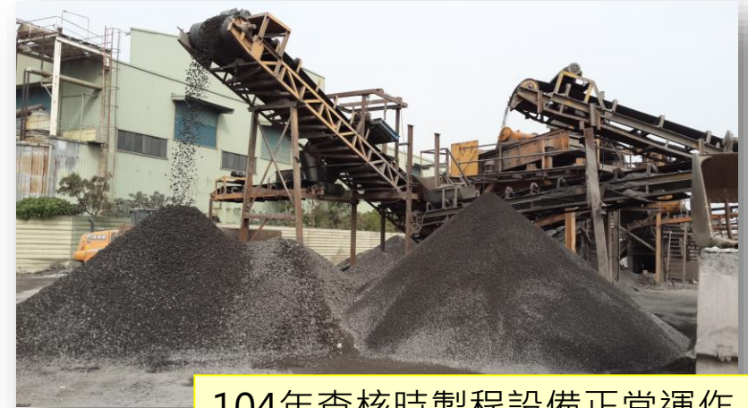
104年查核時製程設備正常運作
