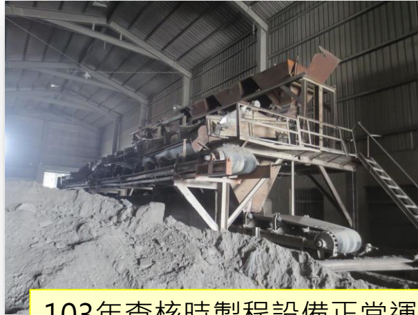
103年查核時製程設備正常運作
