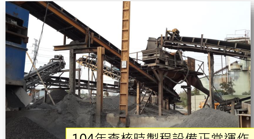
104年查核時製程設備正常運作
