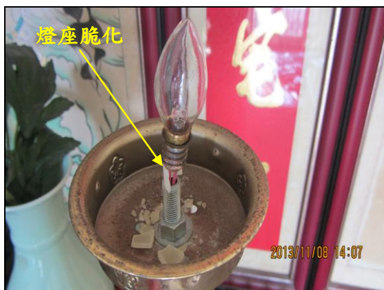
(c) 出現燈座脆裂危險狀況
