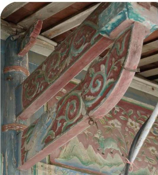
走進這間三合院前埕，放眼望去是典型的三合院格局，整體結構大部分是以大陸福杉木造搭建而成，當時用牛車將木頭從安平運到這，正身接近百年，左伸手約八十年，右伸手約六十年，外牆還保有當時的彩繪和雕刻，屋子經過地震後，只有部分龜裂而已，屋頂會漏水有修補過，在換瓦片時，裡面的木材沒有損壞，內部也只有稍微整理過，卻又不失古老傳統的韻味。
