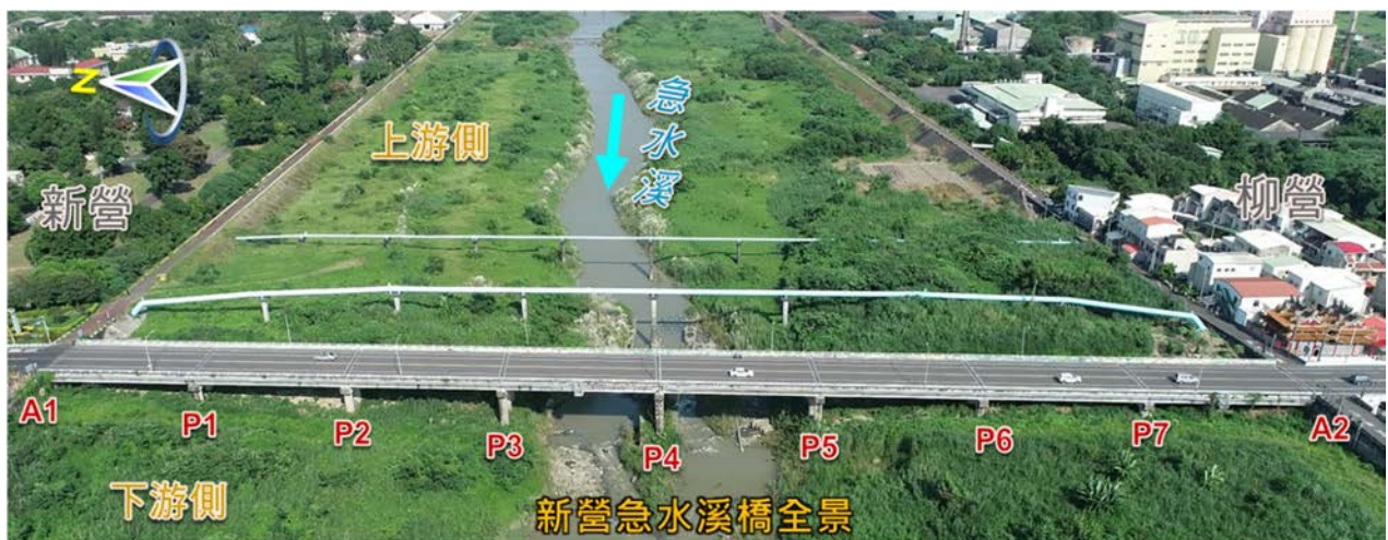
圖 5-1 橋梁空拍全景圖
